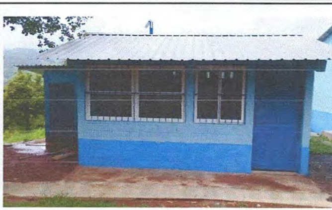
Foto 2: ESTADO ACTUAL DE LA COCINA
