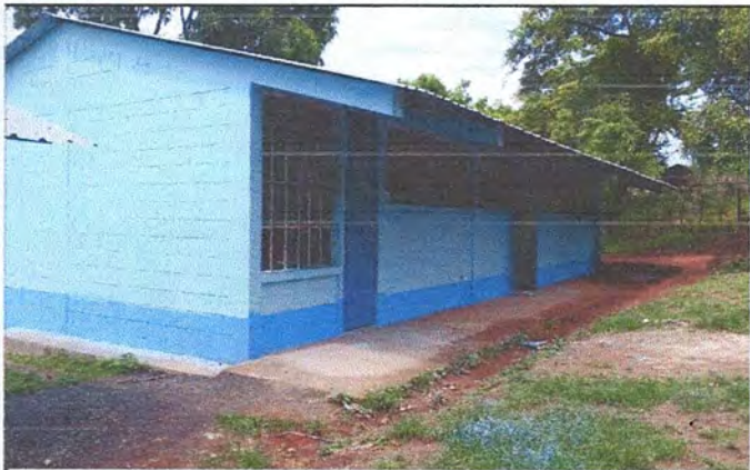
Foto 1: ESTADO ACTUAL DE LAS AULAS
